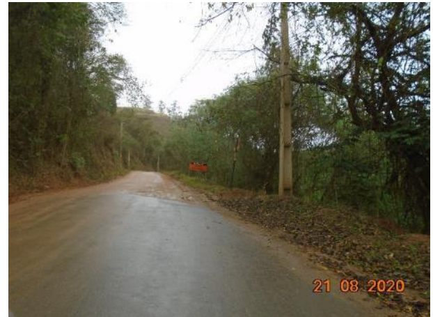
Foto 227 – Placa informativa sobre início de trecho em obras. (Data:21/08/2020)
