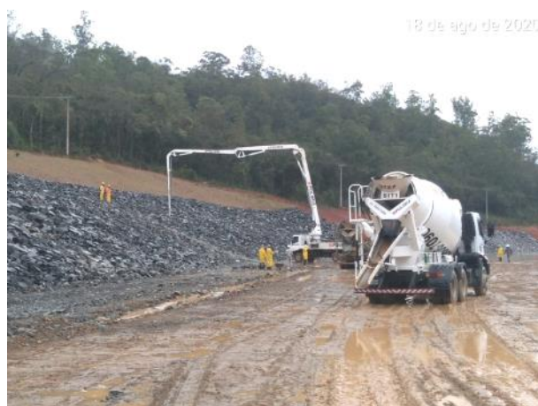
Foto 271 – Concretagem no enrocamento do canal de desvio. (Data:18/08/2020)
