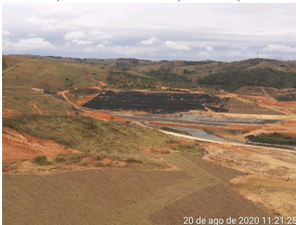
Foto 383 – Bota fora I - Margem Esquerda. (Data:20/08/2020)
