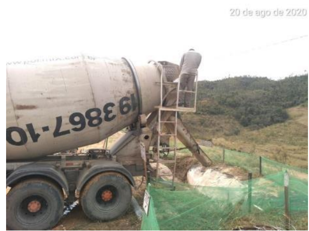
Foto 307 – Lavagem de calha da betoneira. (Data:20/08/2020)
