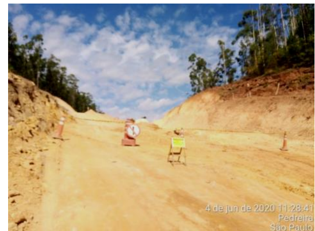
Foto 148 – Área isolada pós carregamento de explosivos. (Data:04/06/2020)
