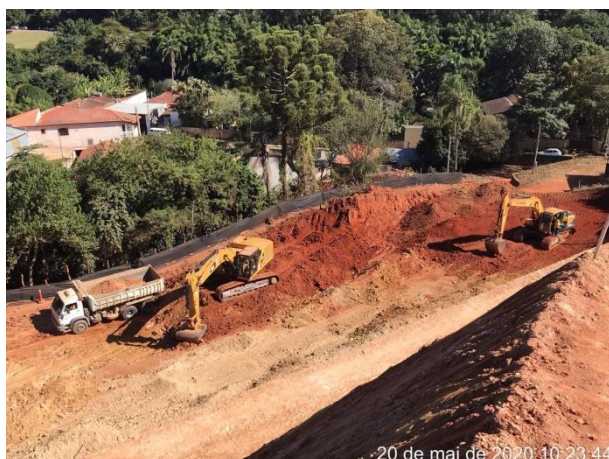
Foto 371 – Movimentação de terra - acesso MD03. (Data: 20/05/2020)
