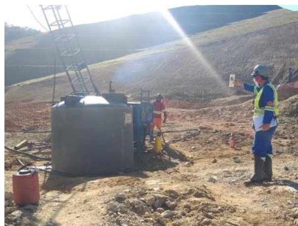
Foto 339 – Monitoramento de fumaça preta em equipamento. (Data:11/06/2020)
