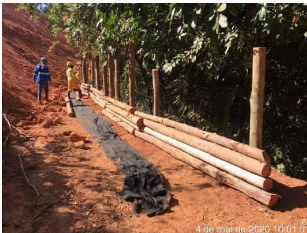
Foto 246 – Instalação de dispositivo de contenção na MD03. (Data:04/05/2020)
