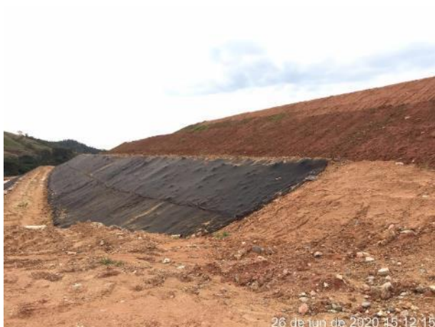
Foto 278 – Inspeção após chuva – Bota fora VII. (Data:26/06/2020)
