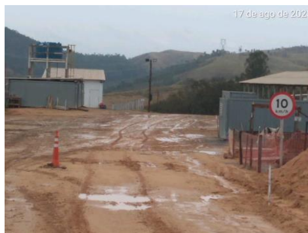
Foto 245 – Sinalização de velocidade máxima permitida no acesso ao canteiro operacional. (Data:17/08/2020)
