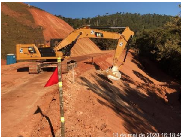
Foto 272 – Conformação de talude após chuva. (Data:18/05/2020)
