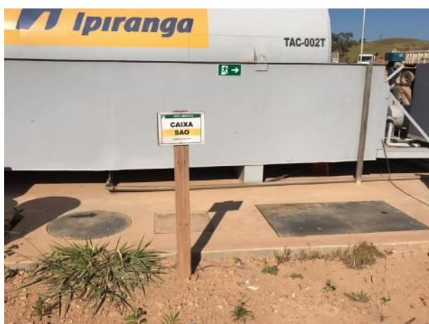
Foto 300 – Identificação da caixa SAO 1 na área de abastecimento canteiro operacional. (Data:28/05/2020)
