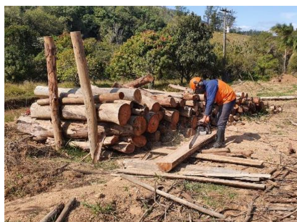
Foto 116 – Reaproveitamento de madeira para pontaletes para placas. (Data:30/07/2020)
