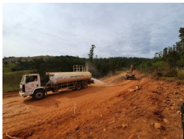
Foto 325 – Umectação de vias internas. (Data:13/05/2020)
