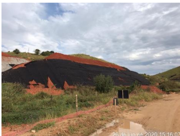
Foto 280 – Inspeção após chuva – Bota espera Colúvio. (Data:26/06/2020)
