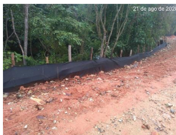
Foto 293 – Inspeção em contenção ambiental. (Data:21/08/2020)
