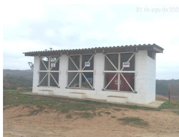
Foto 362 – Baia de resíduos recicláveis no canteiro operacional. (Data:21/08/2020)
