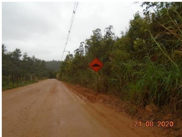
Foto 228 – Placa de sinalização de redutor de velocidade. (Data:21/08/2020)
