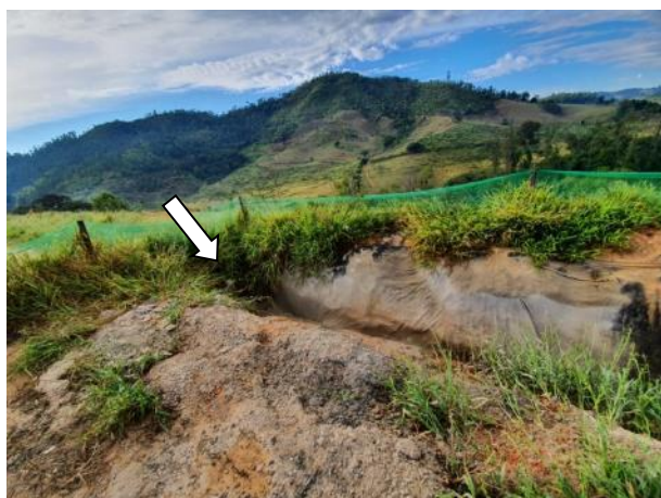
Foto 302 – Calha de lavagem da calha da betoneira. (Data:09/06/2020)
