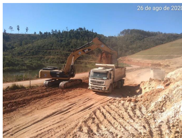
Foto 382 – Movimentação de terra - margem direita. (Data:26/08/2020)
