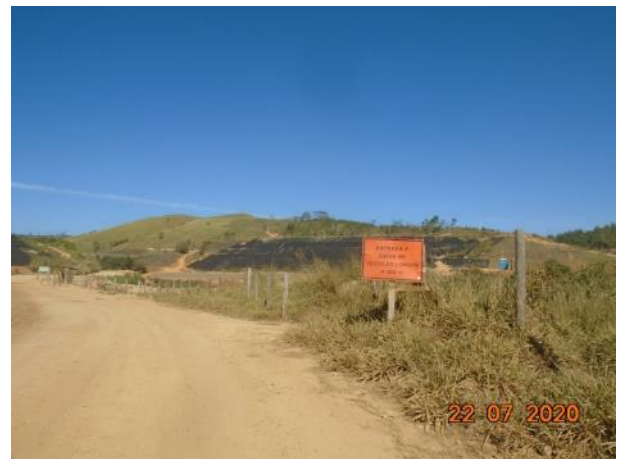
Foto 223 – Sinalização sobre entra e saída de veículos longos na estrada municipal de Pedreira. (Data:22/07/2020)
