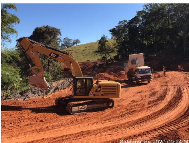
Foto 365 – Movimentação de terra - acesso MD03. (Data:08/05/2020)
