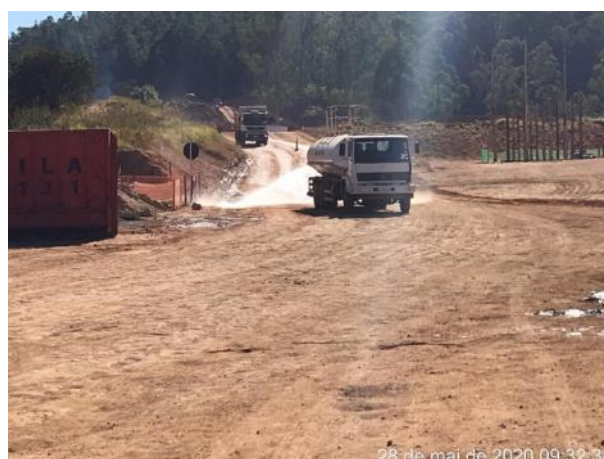
Foto 327 – Umectação no canteiro operacional. (Data:28/05/2020)
