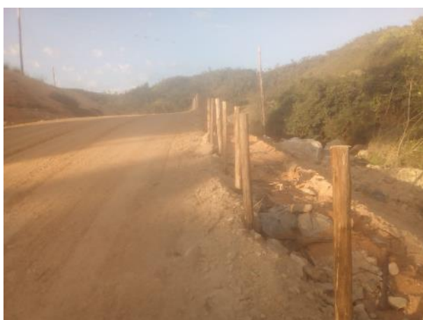
Foto 117 – Reaproveitamento de madeira como anteparo e balizador no acesso M.D.01. (Data:30/07/2020)
