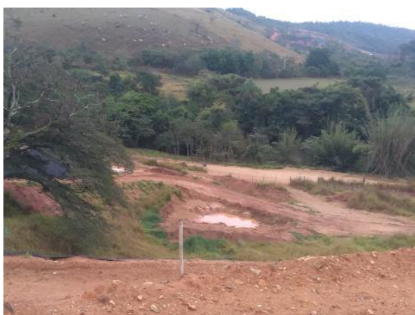
Foto 294 – Inspeção jusante do bota-fora VII M.D. (Data:21/08/2020)
