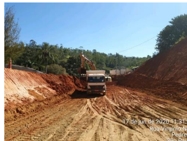
Foto 378 – Movimentação de terra - acesso MD03. (Data:17/06/2020)
