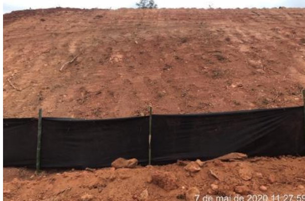
Foto 248 – Registro de implantação de contenção ambiental no desvio MD03. (Data:07/05/2020)
