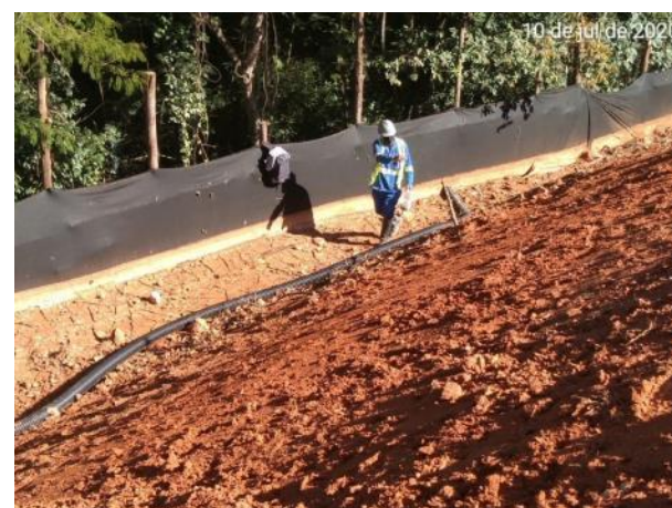
Foto 289 – Inspeção em contenção ambiental. (Data:10/07/2020)
