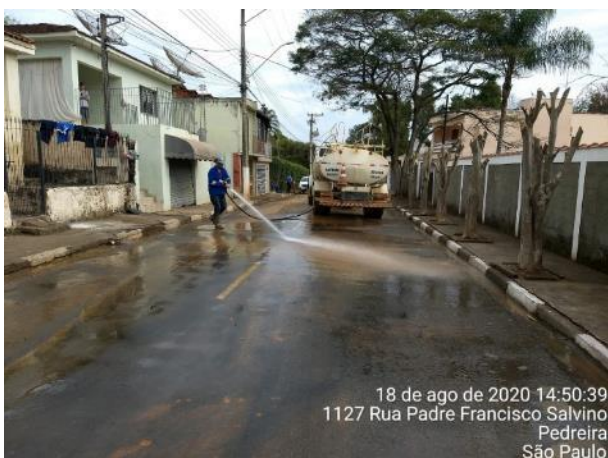
Foto 335 – Limpezas na via externa. (Data:18/07/2020)
