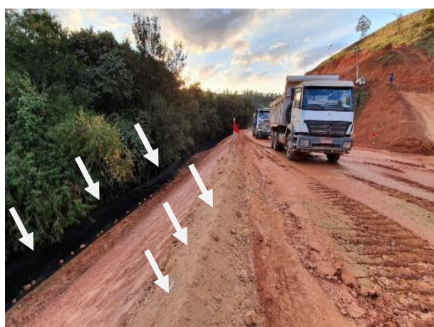
Foto 252 – Contenção implantada em toda M.D.03. (Data:28/05/2020)
