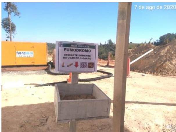
Foto 97 – Identificação de área autorizada para fumar - canteiro operacional. (Data:07/08/2020)
