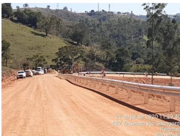
Foto 239 – Defesa metálica implantada no acesso da M.D.03. (Data:21/07/2020)
