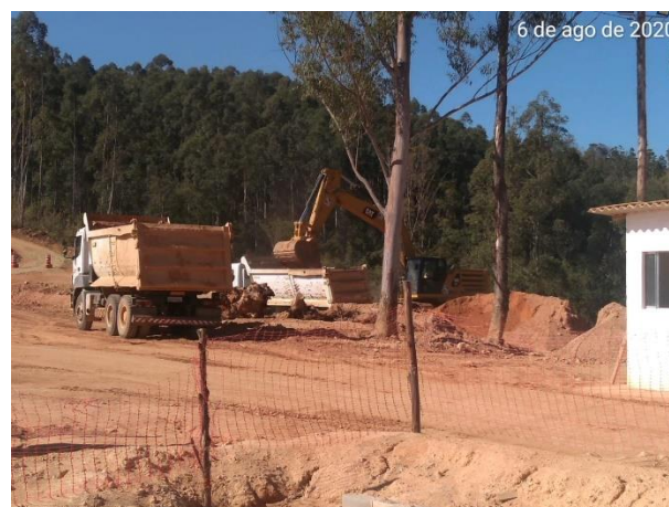
Foto 380 – Movimentação de terra - acesso MD01. (Data:06/08/2020)
