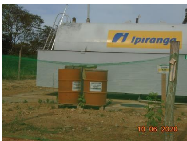
Foto 81 – Kit de emergência ambiental no posto de abastecimento. (Data:10/06/2020)
