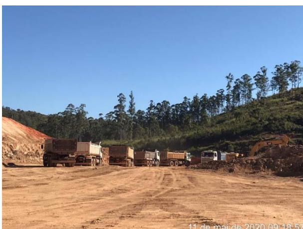
Foto 367 – Movimentação de terra – canal de desvio margem esquerda. (Data:11/05/2020)
