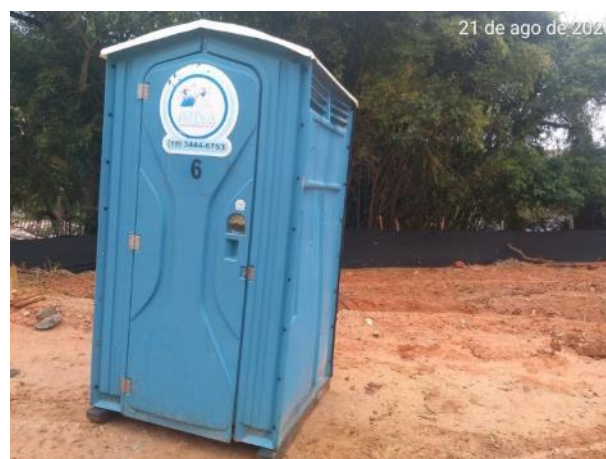
Foto 315 – Banheiro químico instalado na M.D. 03. (Data:21/08/2020)
