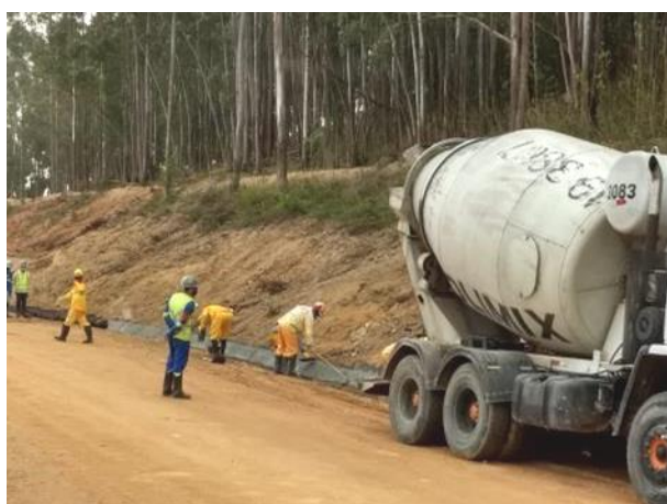
Foto 270 – Implantação de drenagem na MD03. (Data:18/08/2020)
