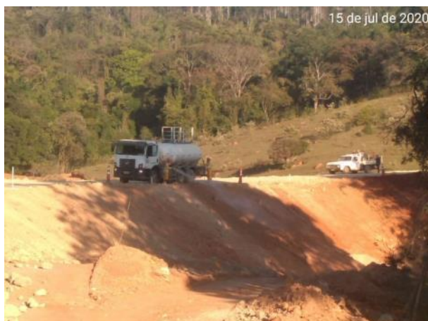
Foto 266 – Rega em plantio de braquiária no talude. (Data:15/07/2020)
