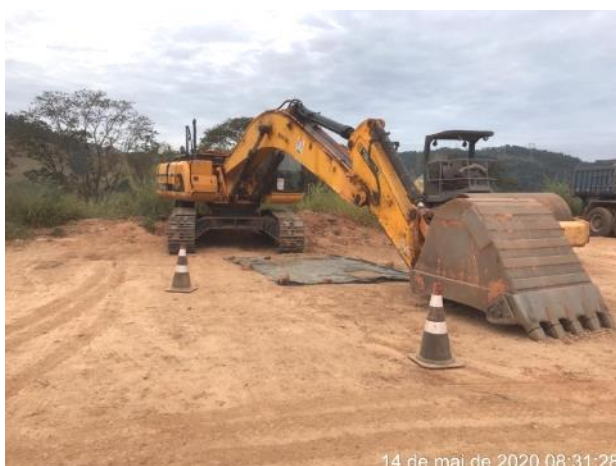
Foto 77 – Área isolada para manutenção de óleo da retro escavadeira. (Data:14/05/2020)
