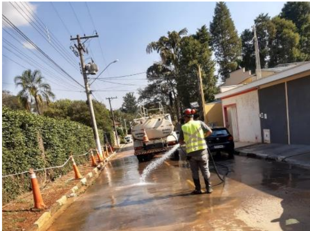
Foto 336– Limpeza via externa. (Data:19/08/2020)
