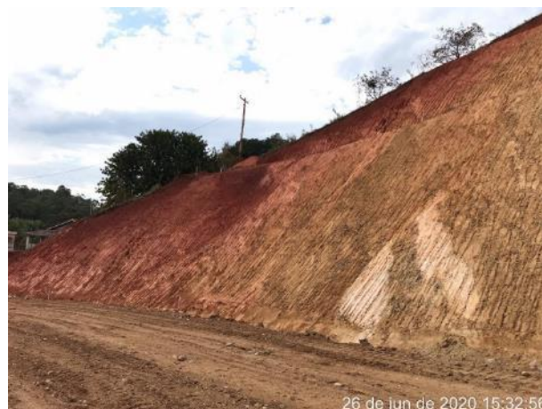
Foto 283 – Inspeção após chuva – talude de corte MD03. (Data:26/06/2020)
