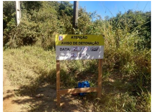
Foto 146 – Aviso de desmonte na estrada municipal de Pedreira. (Data:29/05/2020)
