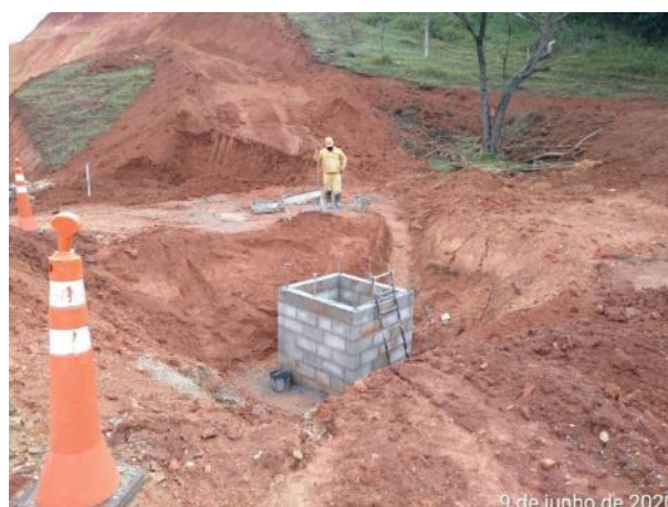
Foto 259 – Implantação de dispositivo de drenagem localizada no desvio MD03. (Data:09/06/2020)
