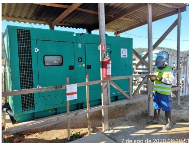
Foto 134 – Inspeção em gerador. (Data:07/08/2020)
