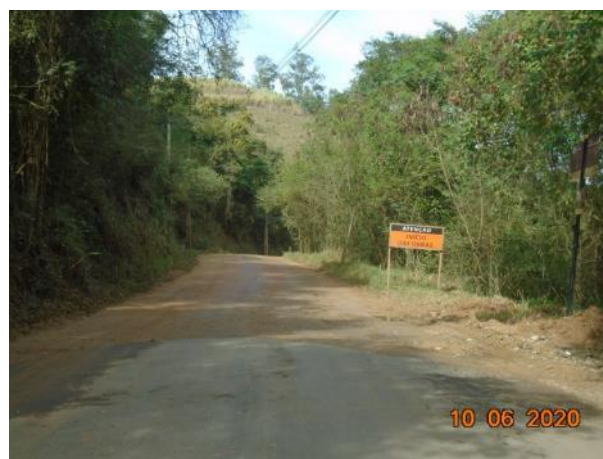
Foto 219 – Sinalização implantada na estrada municipal de Pedreira. (Data:10/06/2020)
