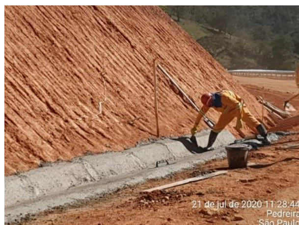
Foto 269 – Implantação de drenagem na M.D.03. (Data:21/07/2020)
