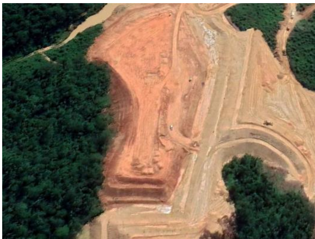
Foto 384 – Imagem do Google Earth - Bota fora II - Margem Esquerda. (Data:18/05/2020)
