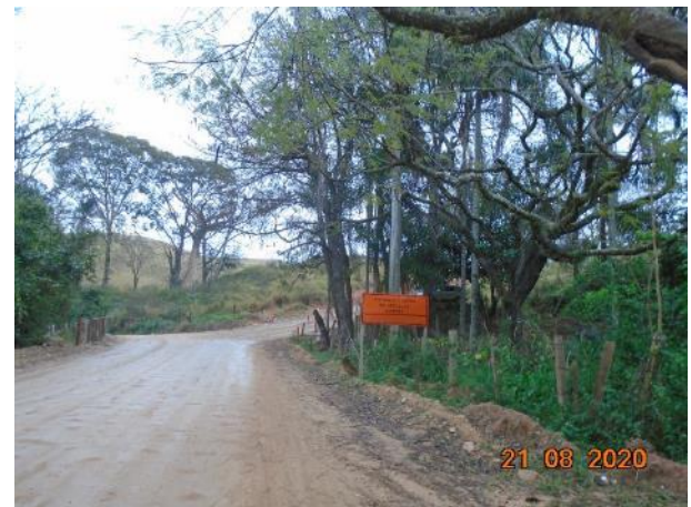
Foto 229 – Sinalização implantada de entrada e saída de veículos longos no acesso do canteiro operacional. (Data:21/08/2020)
