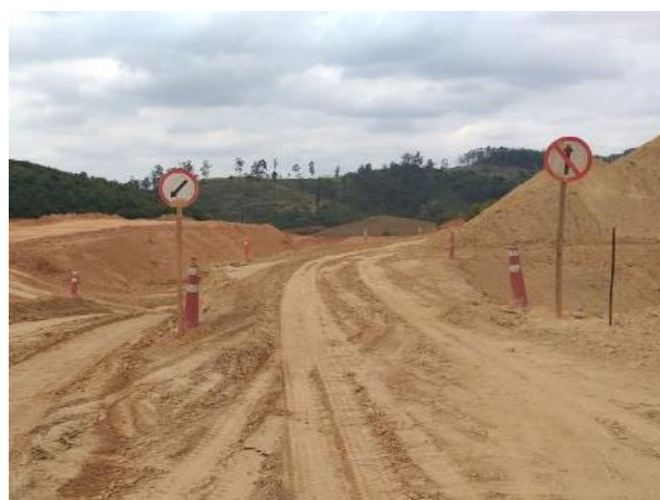
Foto 231 – Sinalização implantada sentido obrigatório de direção e sentido proibido. (Data:15/05/2020)
