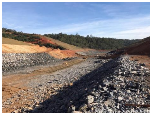
Foto 287 – Inspeção após chuva – canal de desvio M.E. (Data:29/06/2020)
