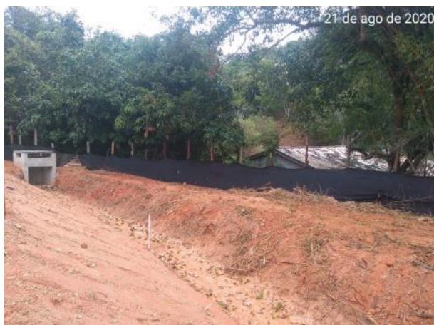
Foto 292 – Inspeção em contenção ambiental. (Data:21/08/2020)
