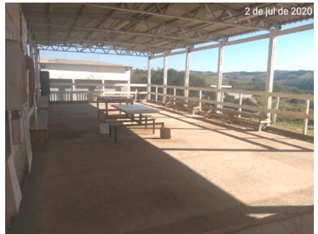
Foto 94 – Organização e limpeza na área de vivência. (Data:02/07/2020)
