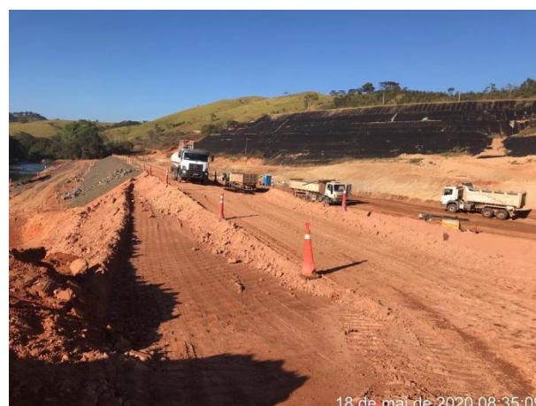
Foto 370 – Movimentação de terra - margem esquerda. (Data: 18/05/2020)
