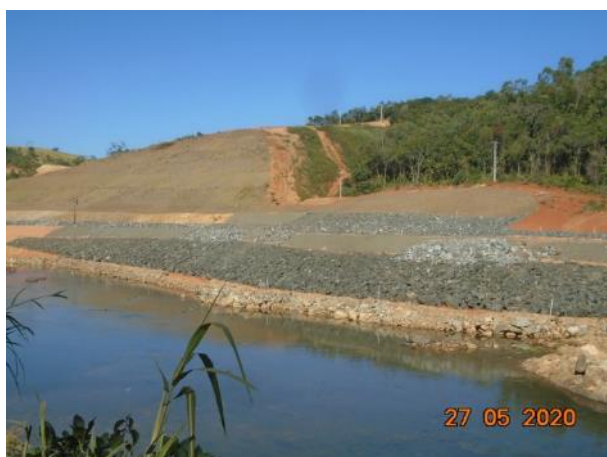
Foto 250 – Enrocamento no canal de desvio. (Data:27/05/2020)
