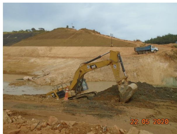
Foto 372 – Movimentação de terra – canal de desvio margem esquerda. (Data: 22/05/2020)
