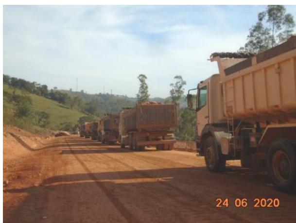
Foto 379 – Movimentação de terra - acesso MD03. (Data:24/06/2020)
