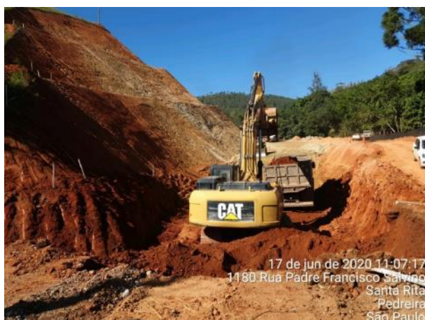
Foto 377 – Movimentação de terra - acesso MD03. (Data:17/06/2020)
