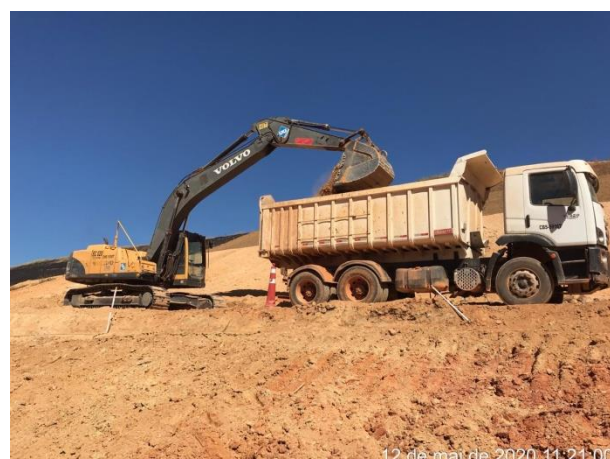
Foto 368 – Movimentação de terra – canal de desvio margem esquerda. (Data:12/05/2020)
