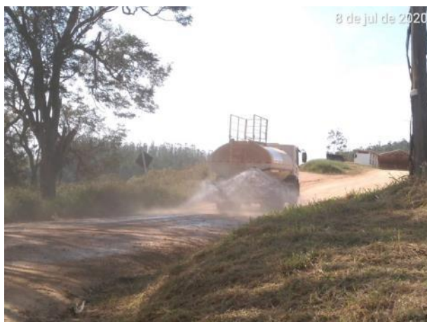
Foto 332 – Umectação nas vias internas. (Data:08/07/2020)
