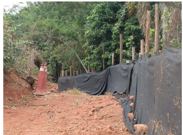
Foto 273 – Inspeção em contenção ambiental, após chuva. (Data:18/05/2020)
