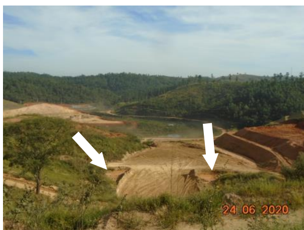
Foto 262 – Cacimbas localizadas no bota-fora I – Margem Direita. (Data:24/06/2020)
