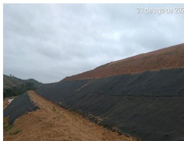
Foto 297 – Inspeção bota-fora V M.D. (Data:21/08/2020)
