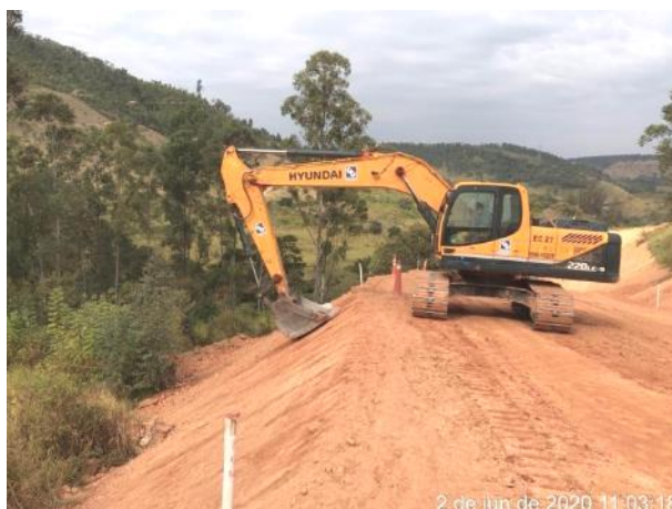
Foto 274 – Conformação de talude após chuva. (Data:02/06/2020)
