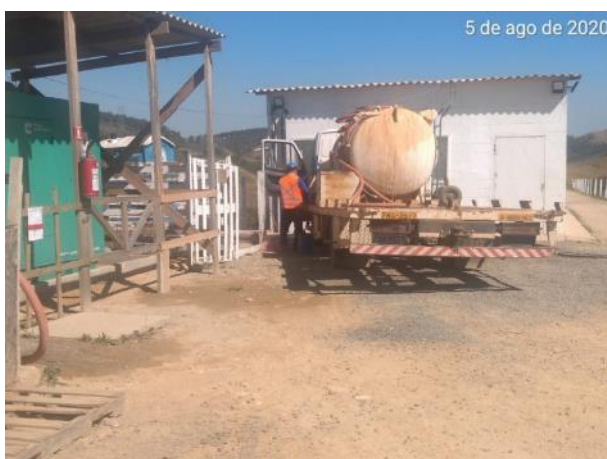
Foto 314 – Higienização em banheiro químico feminino - canteiro operacional. (Data:05/08/2020)
