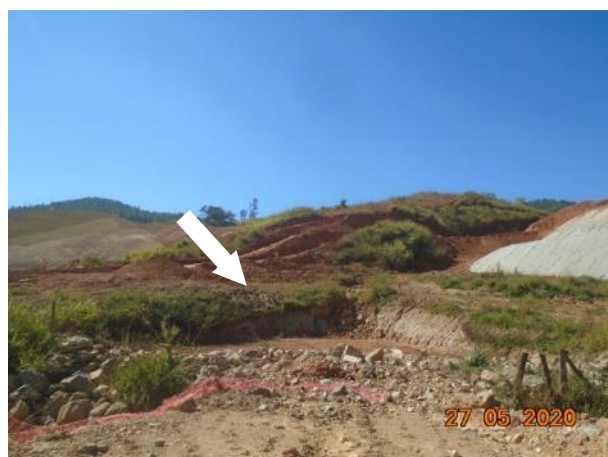
Foto 251 – Cacimba localizada na margem direita próximo ao eixo. (Data:27/05/2020)
