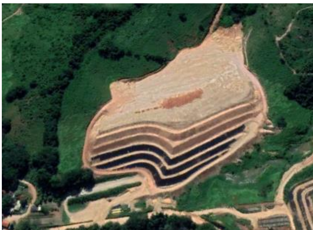
Foto 391 – Imagem do Google Earth - Bota fora VII Margem Direita. (Data:18/05/2020)
