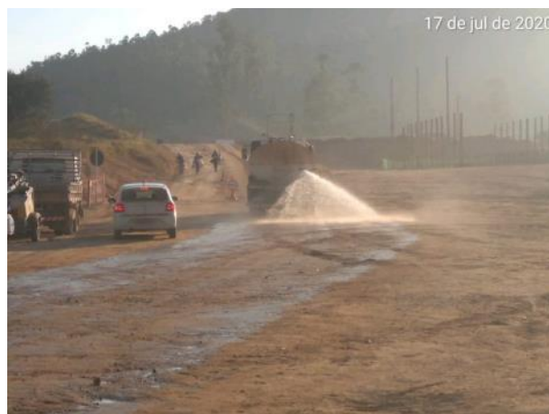
Foto 333 – Umectação nas vias internas - canteiro operacional. (Data:17/07/2020)
