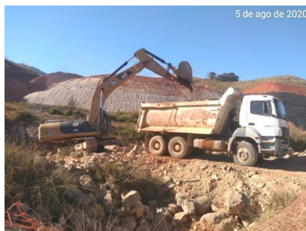
Foto 290 – Limpeza de cacimba próximo ao eixo - margem direita. (Data:05/08/2020)
