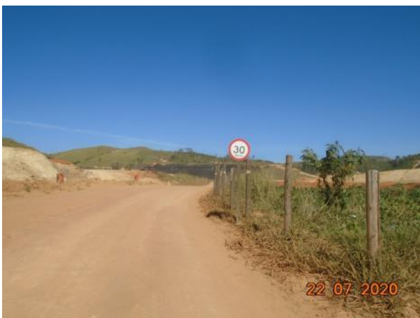
Foto 224 – Sinalização sobre limite máximo permitido de velocidade na estrada municipal de Pedreira. (Data:22/07/2020)
