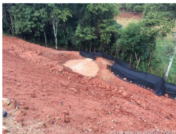
Foto 249 – Cacimba localizada no desvio MD03 e implantação de dispositivo de contenção ambiental. (Data:23/05/2020)
