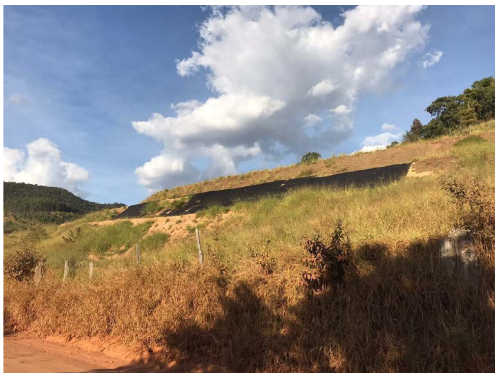
Foto 390 – Bota-fora V – Margem Direita. (Data:21/05/2020)
