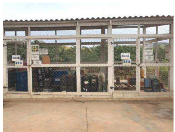
Foto 66 – Baia de produtos químicos no pátio de oficina mecânica. (Data:14/05/2020)
