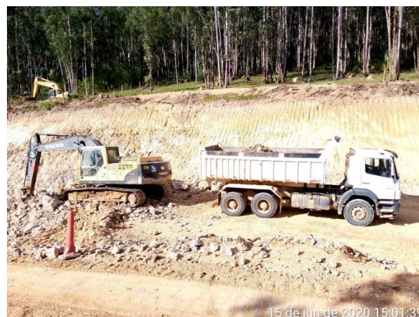
Foto 376 – Movimentação de pedra - acesso MD03. (Data:15/06/2020)
