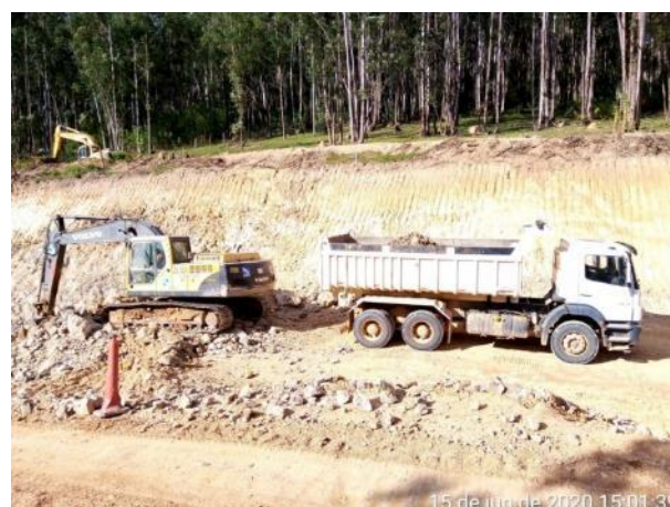
Foto 374 – Movimentação de terra - acesso MD03. (Data: 15/06/2020)
