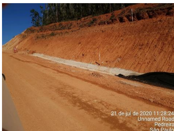
Foto 268 – Implantação de drenagem na M.D.03. (Data:21/07/2020)
