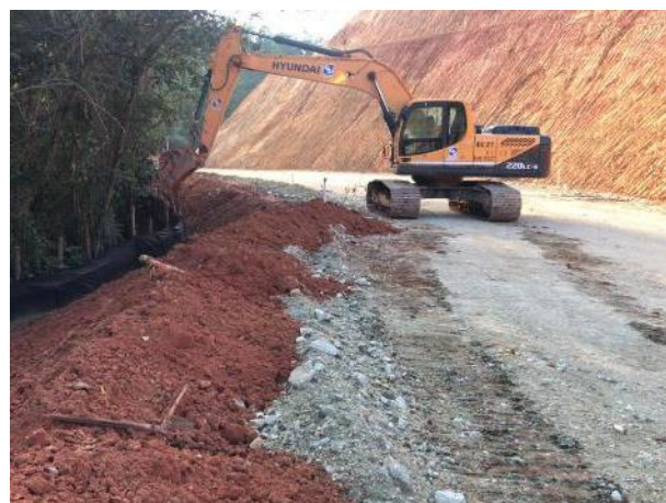
Foto 275 – Conformação de talude após chuva. (Data:08/06/2020)
