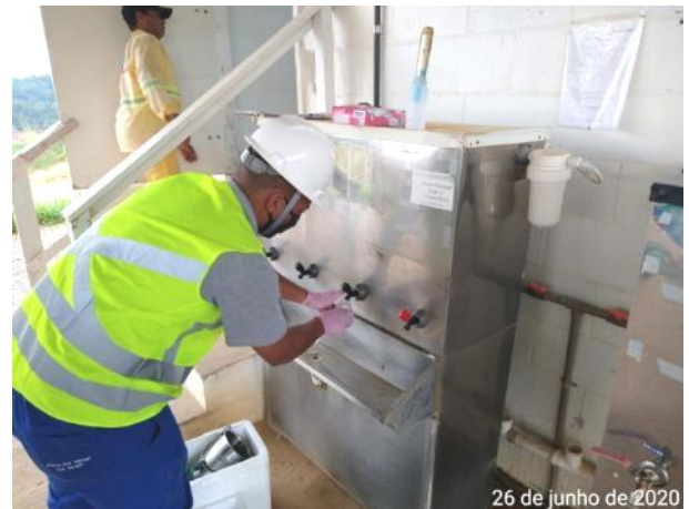
Foto 106 – Coleta de água para laudo de potabilidade do bebedouro no canteiro operacional. (Data:26/06/2020)
