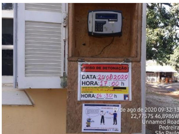
Foto 153 –Comunicado interno sobre a atividade de desmorte. (Data:19/08/2020)
