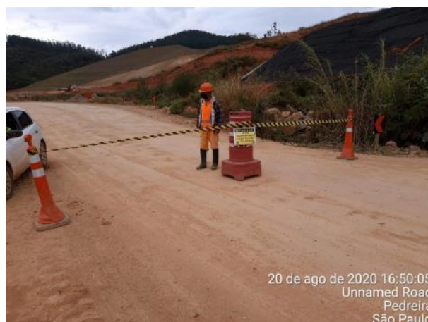
Foto 152 –Bloqueio durante a atividade de desmorte. (Data:20/08/2020)
