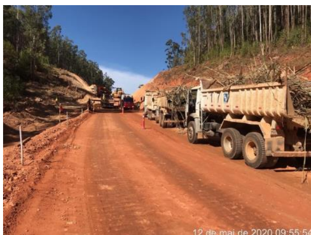
Foto 230 – Sinalização de cones nas obras do acesso da MD03. (Data:12/05/2020)
