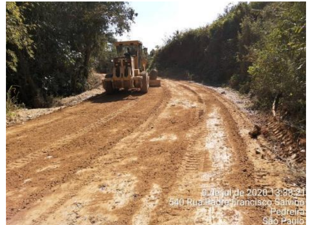
Foto 221 – Melhorias na estrada municipal de Pedreira. (Data:09/07/2020)
