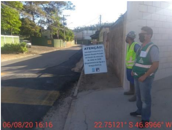
Foto 212 – Comunicação no bloqueio de vias para o desmonte de rocha. (Data:06/08/2020)
