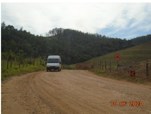
Foto 218 – Sinalização implantada na estrada municipal de Pedreira. (Data:10/06/2020)
