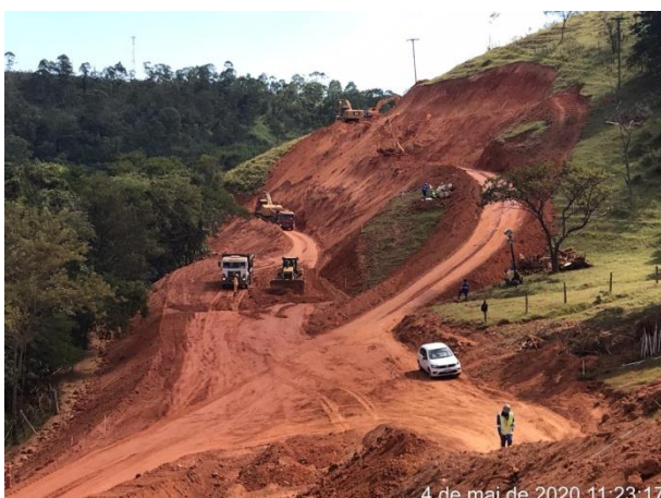
Foto 363 – Movimentação de terra - acesso MD03. (Data:04/05/2020)
