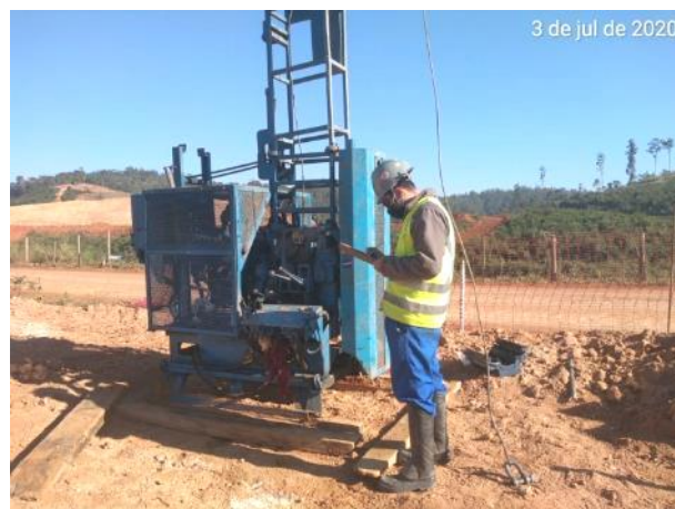
Foto 129 – Inspeção na perfuratriz. (Data:03/07/2020)
