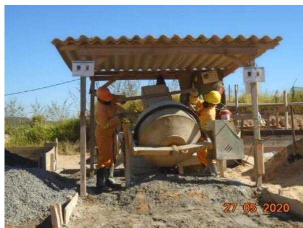
Foto 68 – Betoneira de 400 kg no canteiro operacional. (Data:27/05/2020)
