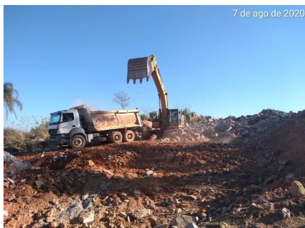
Foto 381 – Movimentação de pedra – acesso M.D.03. (Data:07/08/2020)
