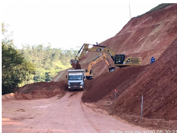
Foto 369 – Movimentação de terra - acesso MD03. (Data: 16/05/2020)
