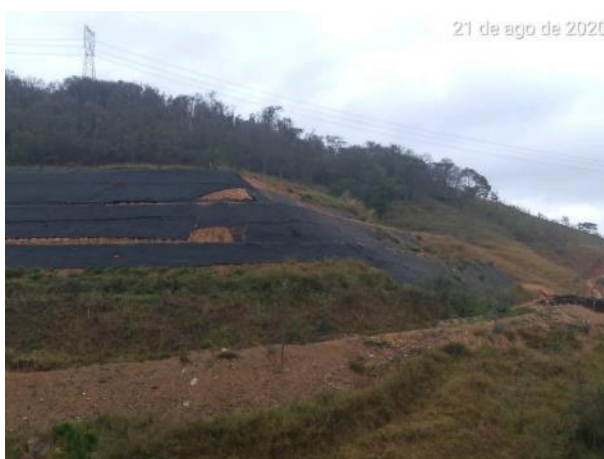
Foto 296 – Inspeção bota-fora IV M.D. (Data:21/08/2020)
