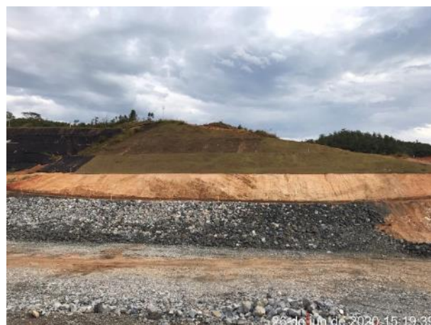
Foto 281 – Inspeção após chuva – talude de corte M.E. (Data:26/06/2020)
