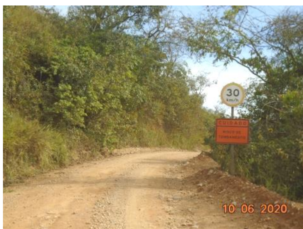
Foto 234 – Sinalização de limite máximo permitido e risco de tombamento no acesso - margem esquerda. (Data:10/06/2020)
