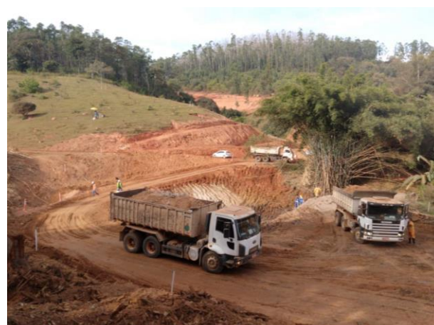
Foto 364 – Movimentação de terra - acesso MD03. (Data:06/05/2020)
