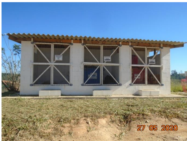
Foto 351 – Baia de resíduos recicláveis no canteiro operacional. (Data:27/05/2020)
