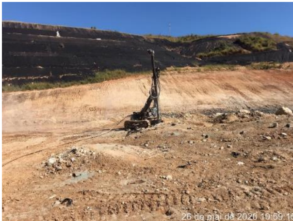
Foto 145 – Perfuratriz realizando os furos no local de desmonte – margem esquerda. (Data:26/05/2020)
