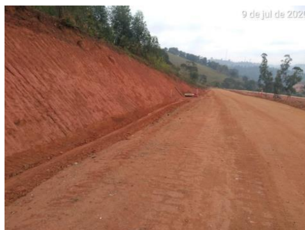
Foto 288 – Conformação de talude. (Data:09/07/2020)
