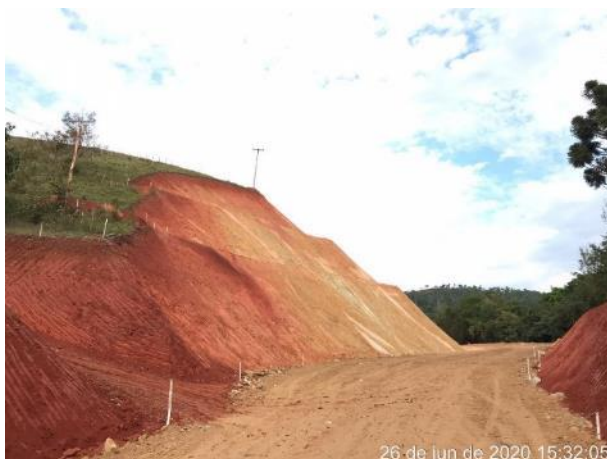
Foto 282 – Inspeção após chuva – talude de corte MD03. (Data:26/06/2020)
