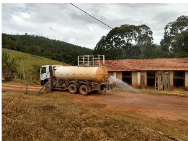
Foto 324 – Umectação de vias internas, acesso M.D.03. (Data:07/05/2020)
