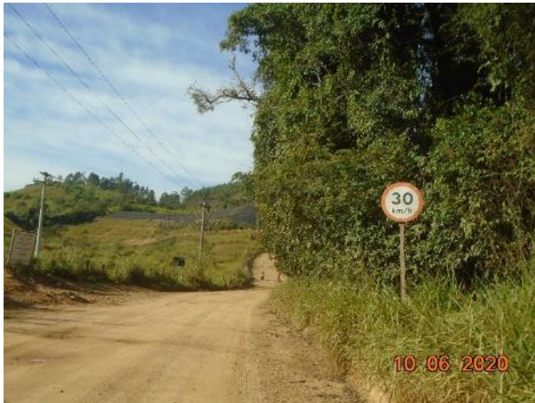
Foto 220 – Sinalização implantada na estrada municipal de Pedreira. (Data:10/06/2020)
