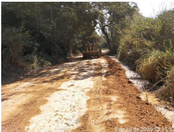
Foto 222 – Melhorias na estrada municipal de Pedreira. (Data:09/07/2020)
