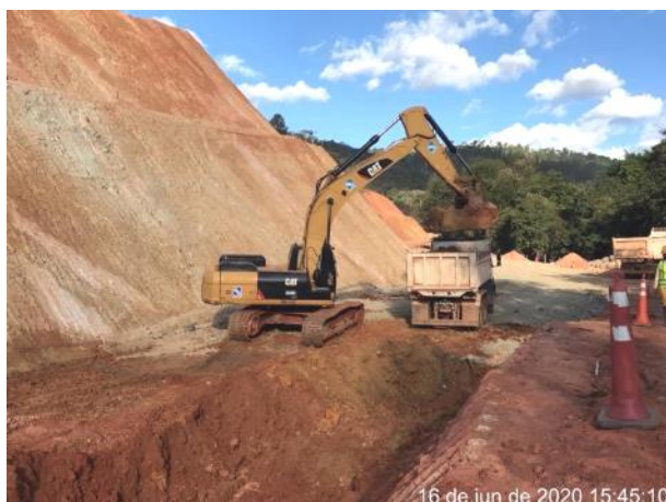
Foto 375 – Movimentação de terra - acesso MD03. (Data:16/06/2020)
