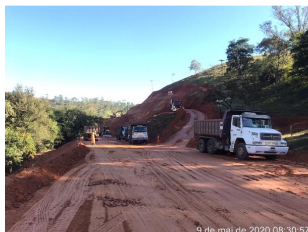
Foto 366 – Movimentação de terra - acesso MD03. (Data:09/05/2020)
