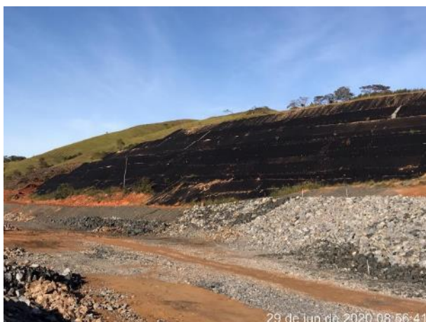
Foto 286 – Inspeção após chuva – Bota fora I M.E. (Data:29/06/2020)
