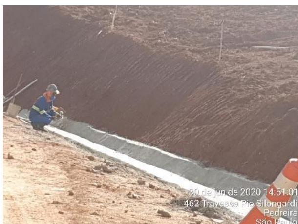
Foto 263 – Canaleta implantada no acesso MD03. (Data:30/06/2020)
