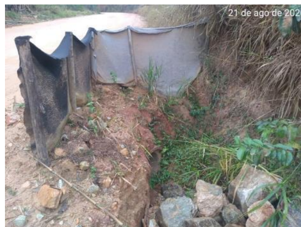
Foto 299 – Inspeção em drenagem existente na Estrada Padre Salvino - próximo ao bota fora IV. (Data:21/08/2020)
