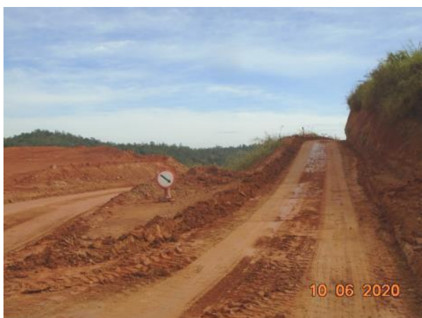
Foto 236 – Sinalização de sentido obrigatório próximo ao canteiro operacional. (Data:10/06/2020)
