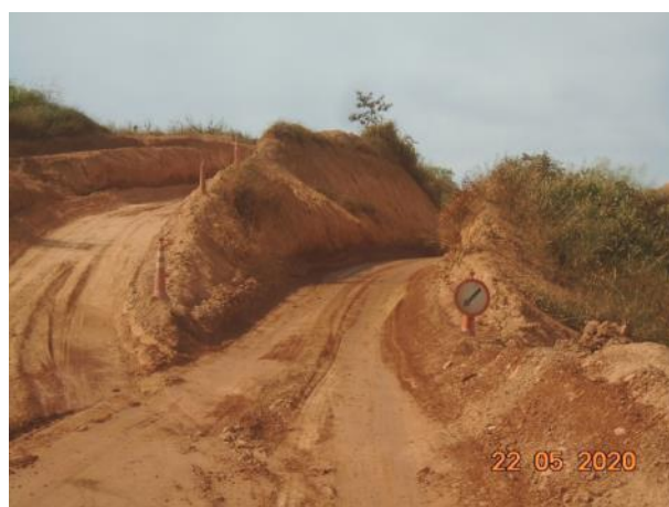
Foto 233 – Sinalização de sentido obrigatório para o acesso ao canteiro operacional. (Data:22/05/2020)
