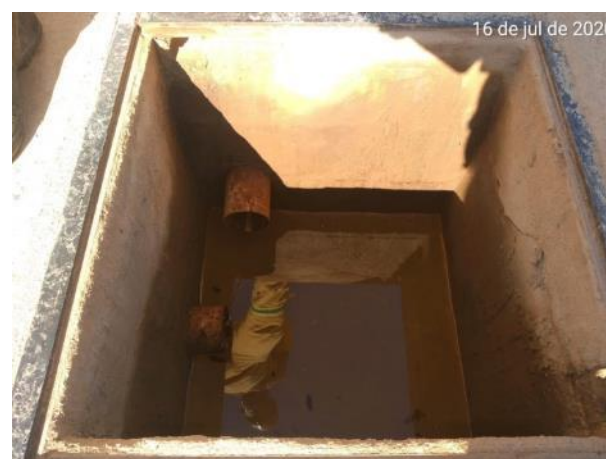
Foto 305 – Inspeção na caixa SAO 1 na área de abastecimento. (Data:16/07/2020)
