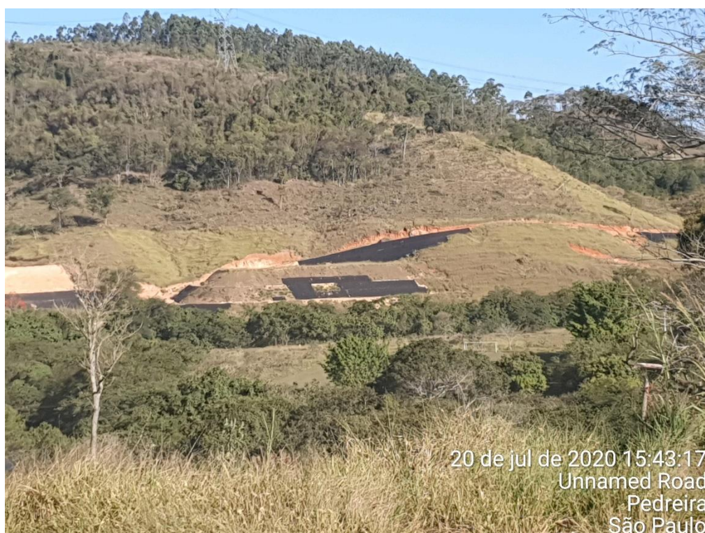
Foto 389 – Bota fora IV – Margem Direita. (Data:20/07/2020)
