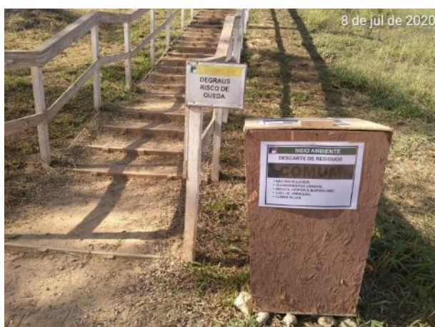
Foto 115 – Reaproveitamento de madeira para confecção de coletor de resíduo. (Data:08/07/2020)
