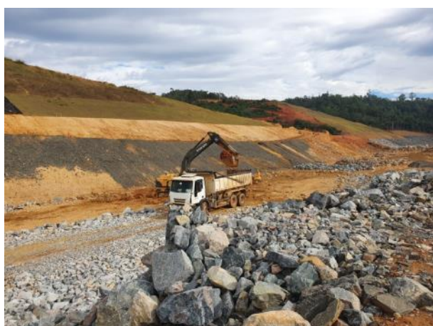
Foto 373 – Movimentação de terra – canal de desvio margem esquerda. (Data: 09/06/2020)
