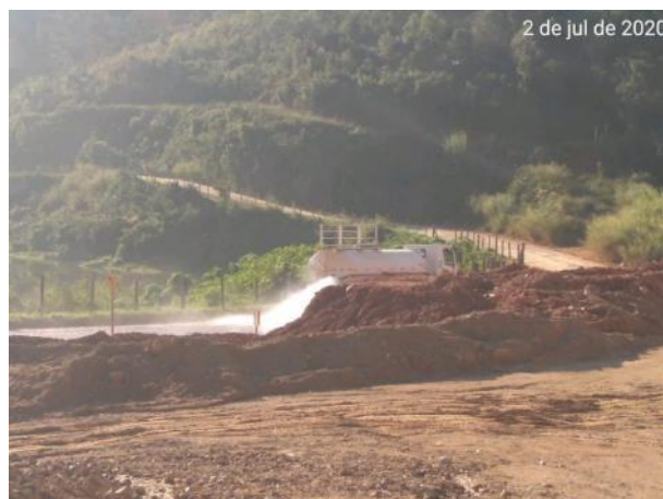
Foto 331 – Umectação nas vias externas - estrada municipal de Pedreira. (Data:02/07/2020)
