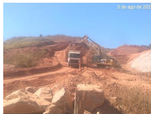
Foto 291 – Limpeza de cacimba - acesso ao canteiro operacional M.D. (Data:05/08/2020)
