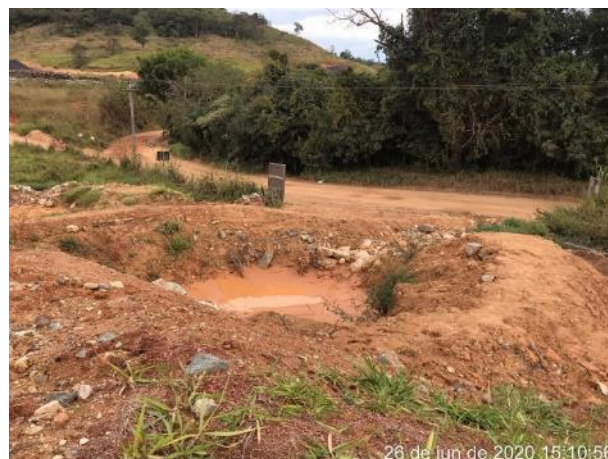
Foto 279 – Inspeção após chuva – Bota fora VII. (Data:26/06/2020)
