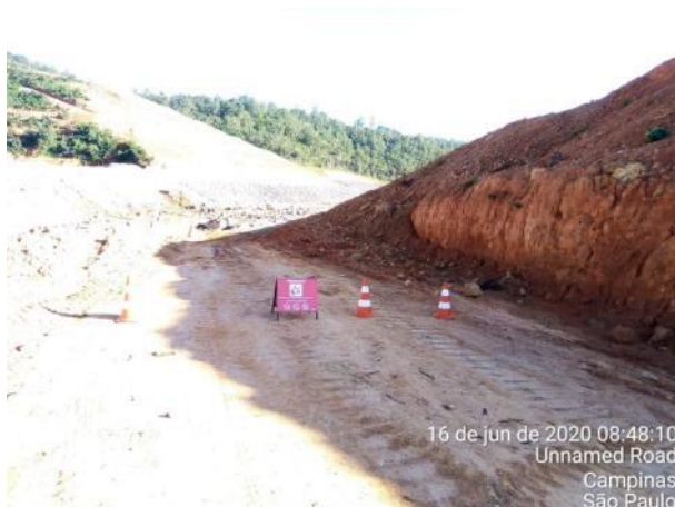
Foto 149 – Isolamento de área durante carregamento de explosivos. (Data:16/06/2020)
